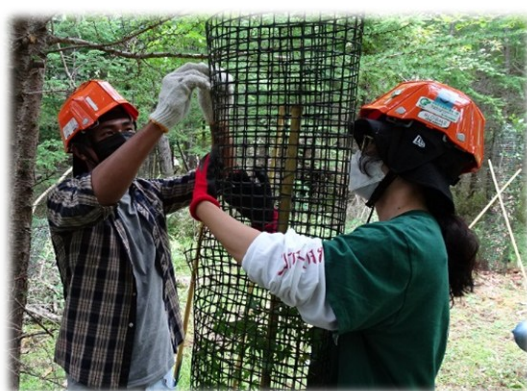
獣害対策防止ネット補修の様子
