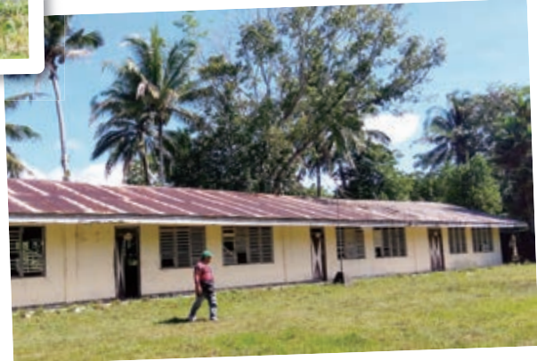
ピニアン研修センターも建物はあるものの、研修は行われていない。敷地の一部はフィリピンコナツ庁が育苗などに活用している
