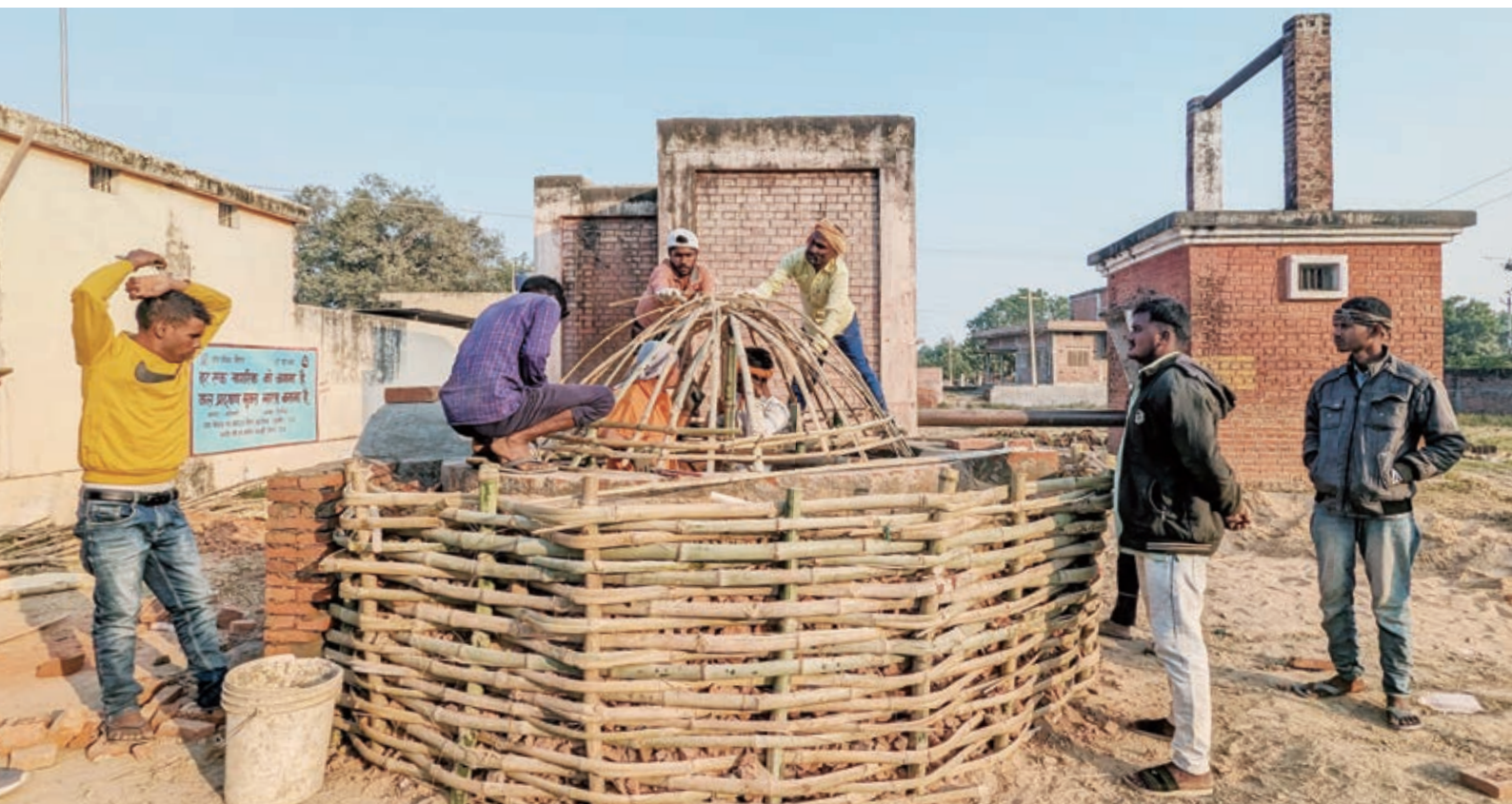
インドで進むプロジェクトでは、竹炭を焼く窯を日本からの専門家と地域住民が共に作り上げた
