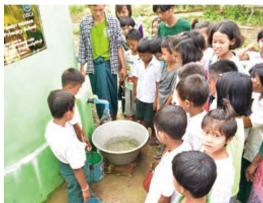
TOTO水環境基金の助成で設置した雨水貯蔵設備。緑化だけでなく、学校菜園活動にも役立てられている（ミャンマー・ビョーボエ郡）
