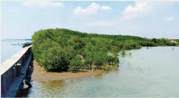
上／ヒューム管の中に人力で砂を詰める作業は、満潮時に行われる重労働 下／防波堤の後ろにはマンングローブが育ち、土壌の堆積も進んでいる
