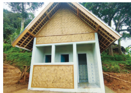
3年次の事業で完成した共同水場
