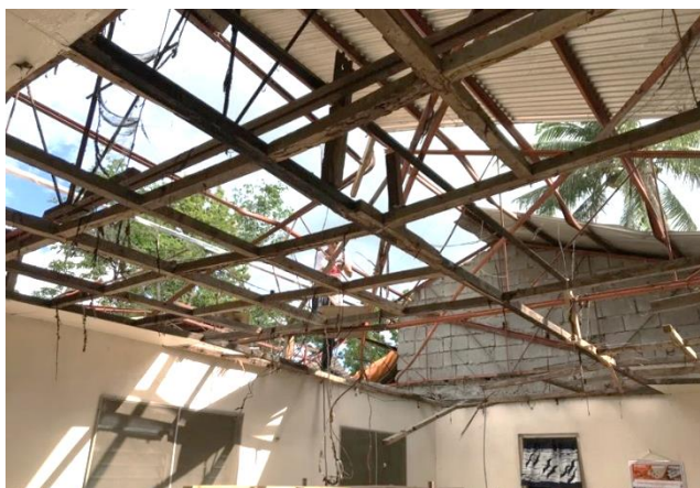
天井と屋根の修理（3月1日）
