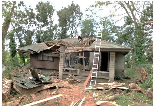
屋根の損傷部分を取り除く様子（1 月 31 日）
