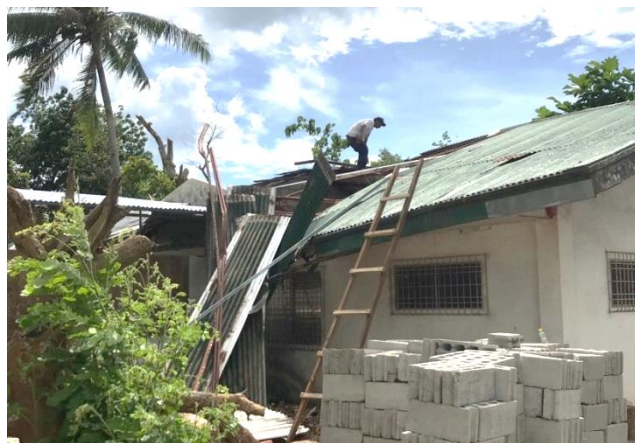
ダイニングの建物を修理する様子（5月4日）
