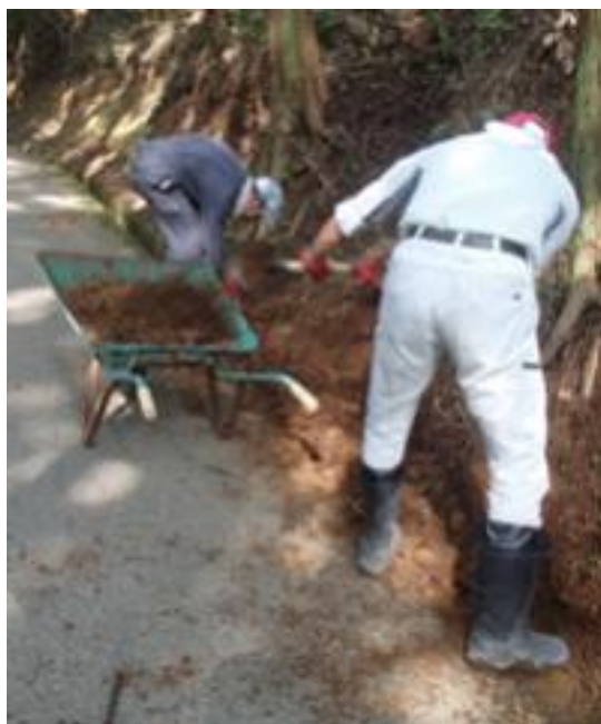
側溝の泥出し作業の様子
