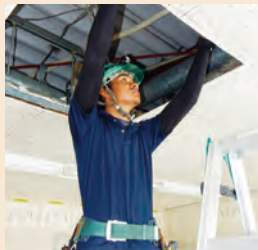
天井エアコンの施工(アミン)
