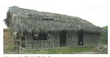
ザヤマ小学校旧校舎
