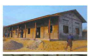
建設工事中の校舎の様子
