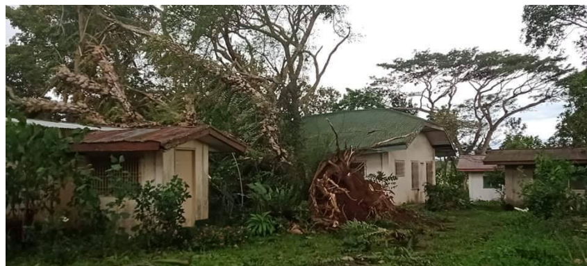
研修センター内の写真です。 木が飛んできて屋根が壊れたりしています。
