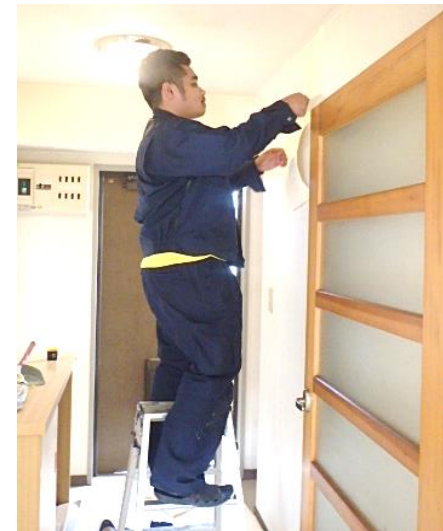
技能実習生マレーシアのザイムル 内装の研修中 於：(有)大地企画(大分市)
