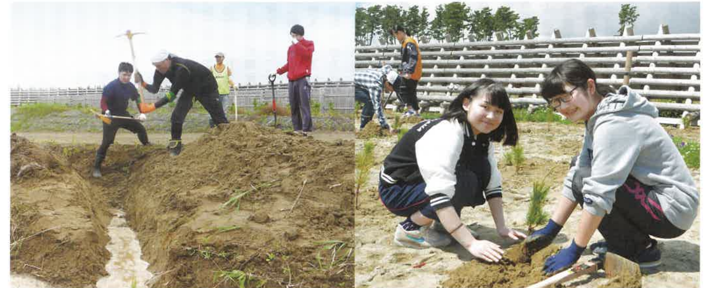
慣れないツルハシで排水路を掘るボランティア (2018年6月)
