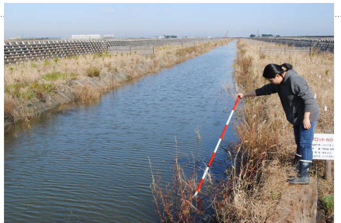
名取市海岸林中央部から北の多湿地帯全景。凝灰岩質砂岩の盛土土壌、瓦礫仮置場としての転圧、サイクリング道工事による排水抑止、ヘドロ混入などの影響も加わり多湿箇所が非常に多い
