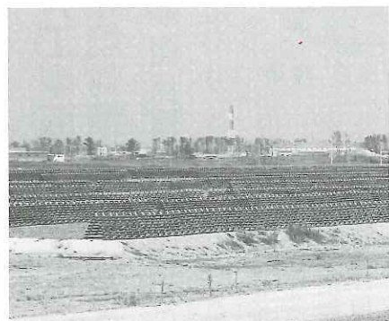
▲ 造成が完了した海岸防災林生育基盤 (北釜地区)
